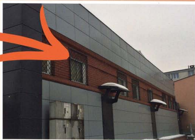
Stosowanie nowatorskich elewacji ceglanych na płytach elewacyjnych cemoentowo-drzazgowych
