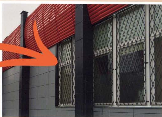
Zastosowanie płyt elewacyjnych cemoentowo-drzazgowych, malowanych proszkowo na ruszcie samonośnym
