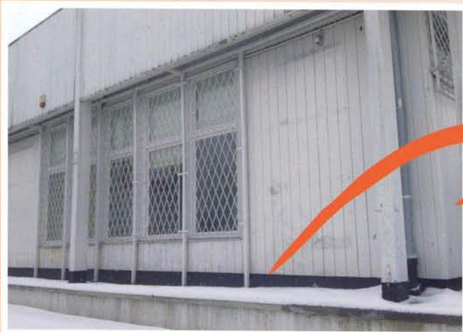
Zastosowanie płyt elewacyjnych cemoentowo-drzazgowych, malowanych proszkowo na ruszcie samonośnym
